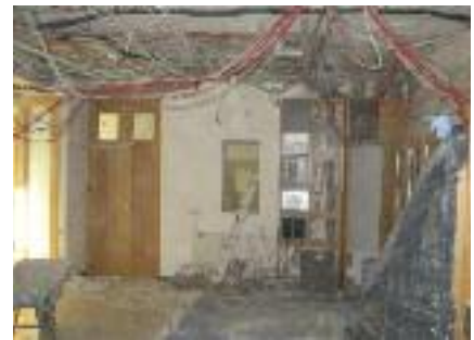
Die entkernte Eingangshalle der Kreisklinik Berchtesgaden.
