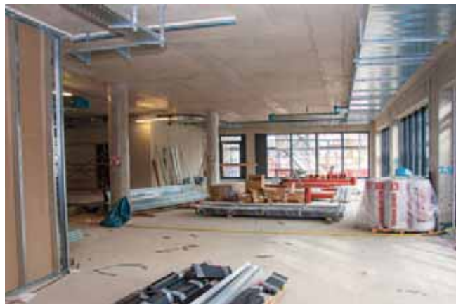
▲ Der Innenausbau passiert flexibel in Trockenbauweise. ganz oben, die Fassade war bis Jahresende fertig.
