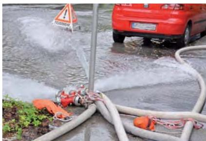
Fünf Pumpen arbeiten mit einer Kapazität von fünf Kubikmeter pro Minute, um das eindringende Wasser abzapumpen.
