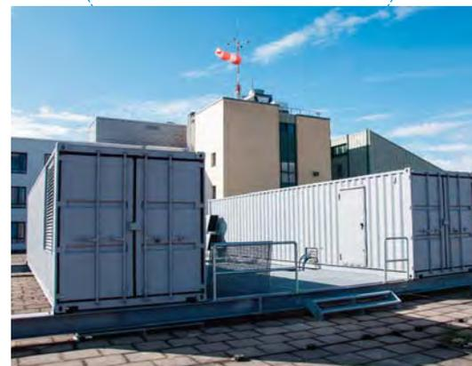
▲ Die neue Druckluftzentrale steht auf dem Klinikdach in zwei Containern.
